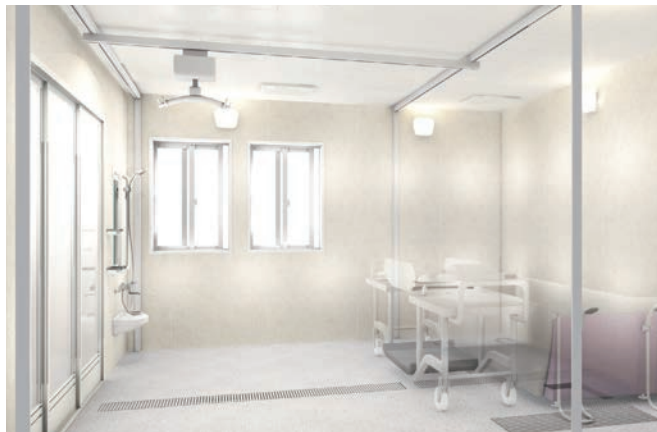
介護入浴機器（機械浴槽）+天井走行リフト設置
