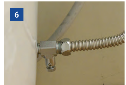
水抜き栓を閉める。
